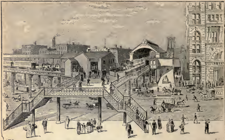
Estacion del Ferrocarril Elevado de la Tercera Avenida cerca de la "City Hall" y Entrada al Puente de Brooklyn.
